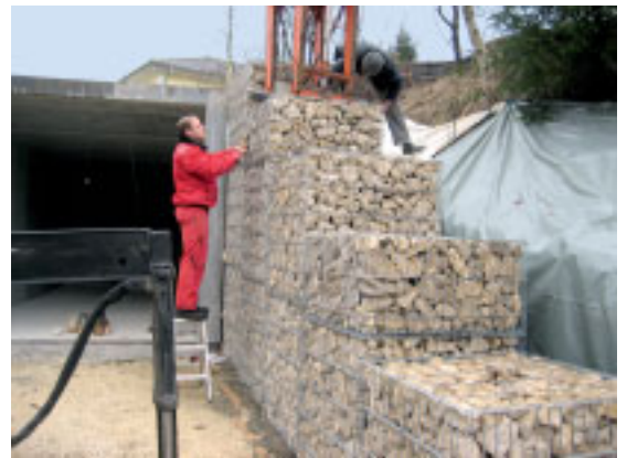
Gabionen als Stützmauer
