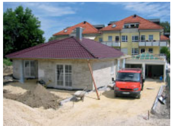
Schönes Einfamilienhaus in Günzburg
