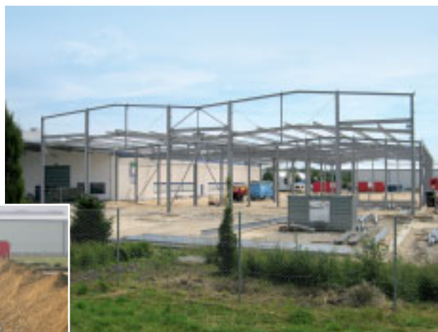
... und schon steht das Hallengerüst.
