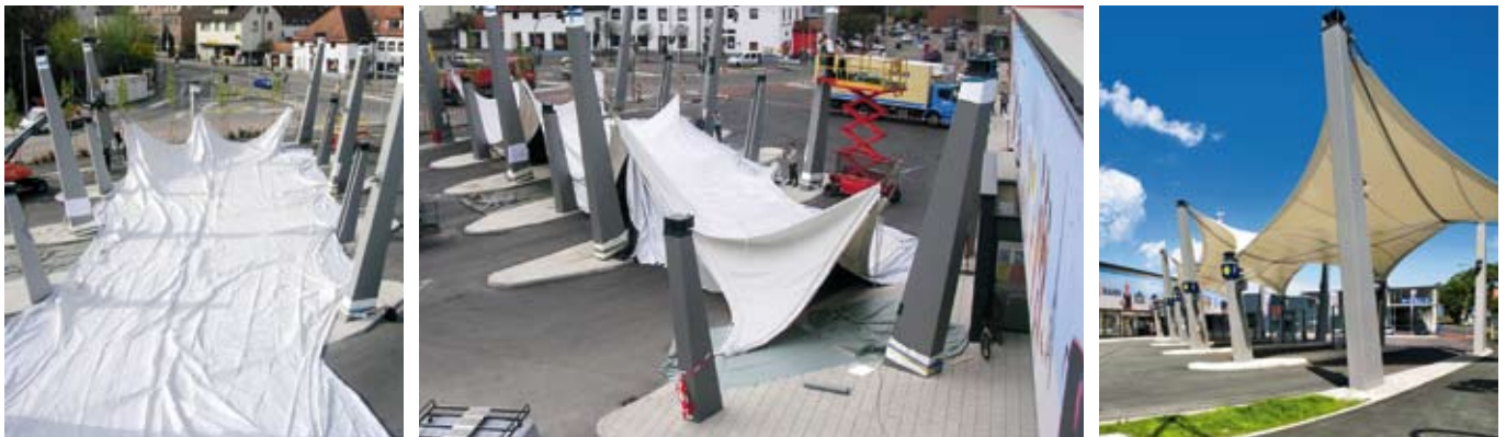
Das Zeltdach über den Bushaltestellen wird montiert.
