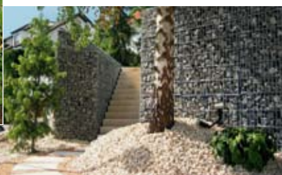
▲ Gabionen – die moderne Alternative zur Betonmauer.
