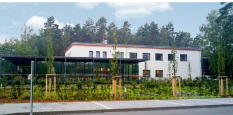
Kantine Forschungszentrum Rossendorf
