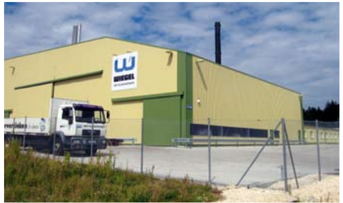
▲ Schlüsselfertiger Neubau einer Feuerverzinkerei in Günzburg Auftragserteilung durch die Firma Wiegel, GmbH & Co.KG Bauausführung mit kombinierter Stahl- und Holzbauweise.
