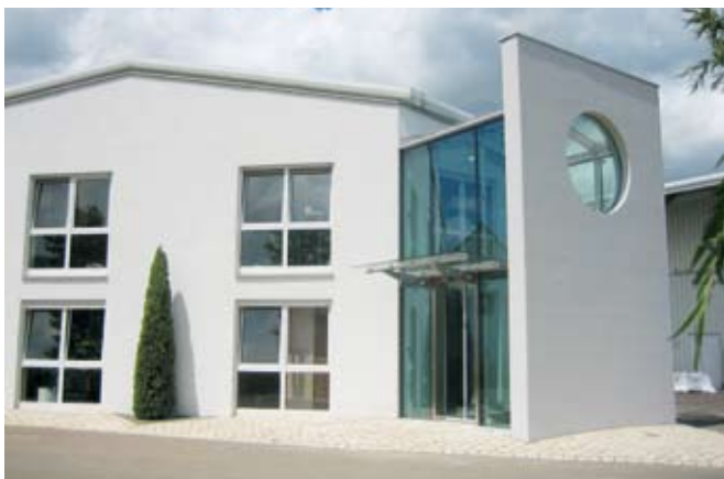
▲ Anbau eines Windfang-Elements an ein bestehendes Betriebsgebäude Auftraggeber: Firma Zill GmbH & Co.,KG Ausführung in Ortbeton
