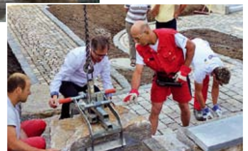
Versetzen von schweren Natur- steinblöcken
