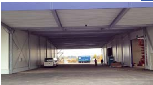
Die neuen Hallen der Günzburger Steigtechnik Munk mit überdachter Verbindung
