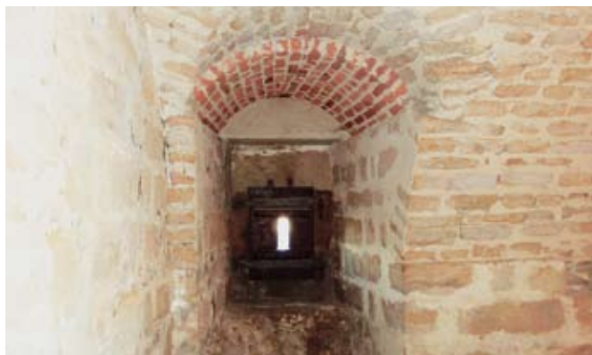
Saniertes Gewölbe in der Festung Königstein
