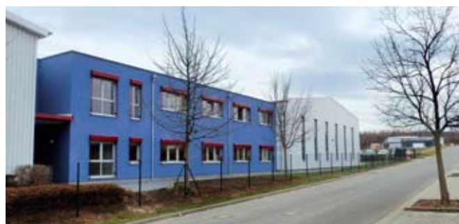
Neubau Fa. Bauer, Leupoldishain
