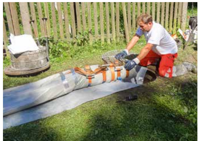
Rainer Mayr prüft den Liner, bevor er über den Schacht eingebaut wird
