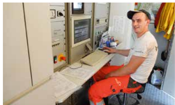
Mateusz Depta überwacht die Sanierungsarbeiten am Monitor
