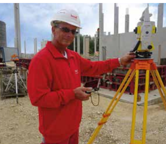
Polier Frank Tomcala-Hieber beim schnellen und zuverlässigen Messen von Winkeln und Distanzen mit einer Totalstation. Alle Messwerte und Zusatzinformationen können auf den internen Speicher und dann auf mobile Datenträger übertragen werden. Das spart viel Zeit und Nerven.
