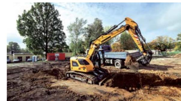
In **Neustadt/Sa.** vergrößert sich das Autohaus Rußig um eine neue Kfz-Werkstatthalle. Für die umfangreichen Erdarbeiten mit ca. 1.000 m<sup>3</sup> Aushub fahren wir schweres Gerät auf. Zu unseren Aufgaben gehört die Herstellung der Punkt- und Streifenfundamente sowie der Bodenplatte. Sämtliche Grundleitungen unter der Halle werden von uns verlegt, ebenso die Zwischendecke für die neue Büroeinheit. Die Halle selbst wird als Stahlkonstruktion mit Mauerwerk errichtet.
